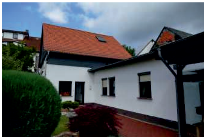
◁ Fertiges Hinterhaus mit verbindendem Mitteltrakt
