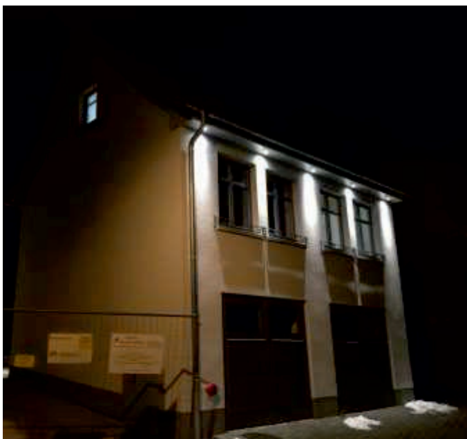
Neue Außenbeleuchtung bei Nacht
