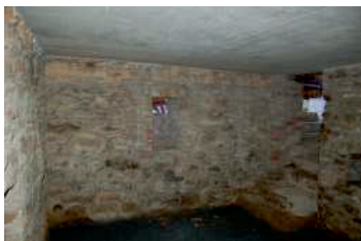
Der Gewölbekeller mit neuer Deckenplatte
