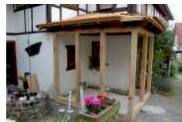
Der Küchenanbau entsteht
