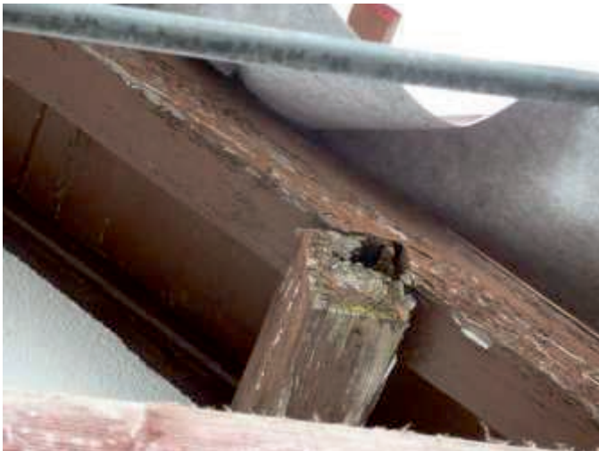
Schadhafte Dachbalken
