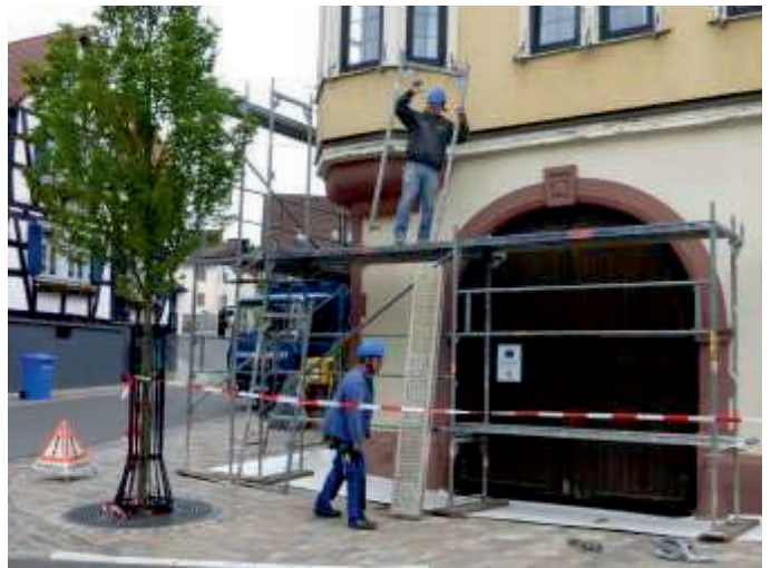
Beginn der Einrüstung
