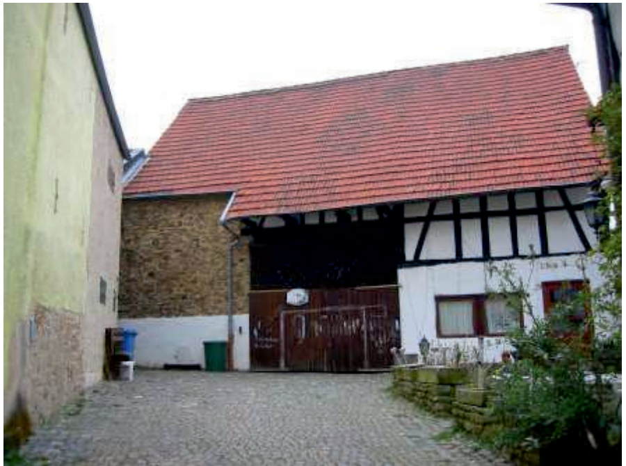
Die Scheune mit altem „Bretterverschlag“-Tor und darüber mit dunklen Brettern verschlossener Fläche (Foto oben)
