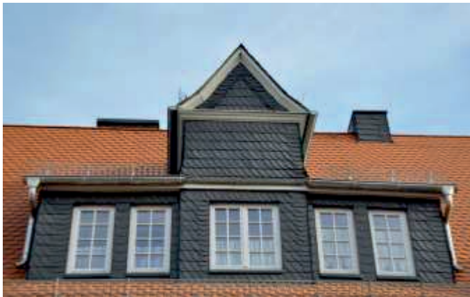
Detail der fertigen neuen Dacheindeckung
