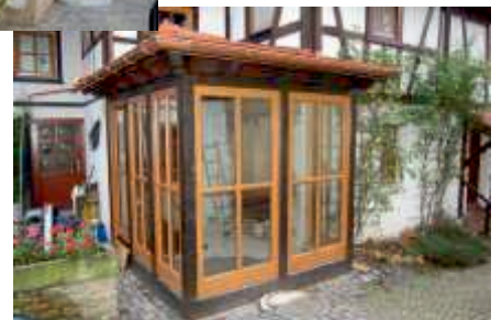
Der fertige Küchenanbau
